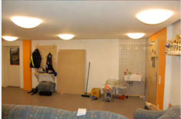
So wird der Jugendraum von St. Martin nach der geförderten Renovierung, die in Eigenregie der Jugendlichen in Eigenleistungen und von Fachfirmen seit Herbst 2015 durchgeführt wird, nicht mehr aussehen!
