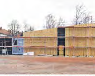
Es geht voran: Vom neuen Jugendtreff in der Neugablonzer Turnstraße steht bereits der Rohbau. Der Stadtjugendring hofft, die Einrichtung im Sommer eröffnen zu können. Foto: Mathias Wild
