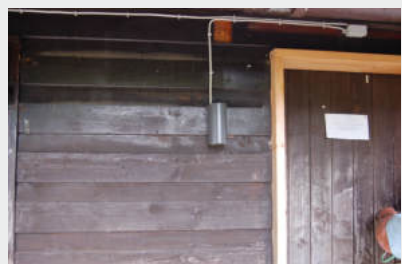
Vier Fotos von der Renovierung des Jugendraums des BSK Olympia – Erneuerung der Elektroinstallationen nach einem Wasserschaden, abgeschlossen im Jahr 2018.
